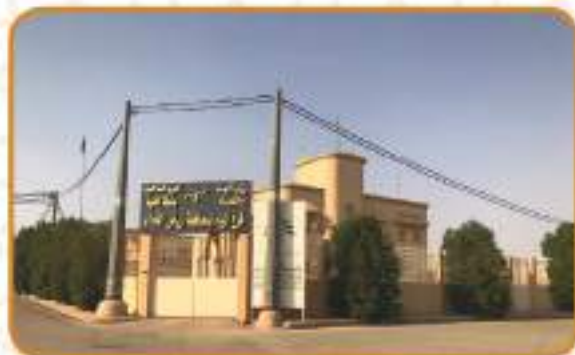
مبنى فرع المياه طريق الإسكان حي التعاون
