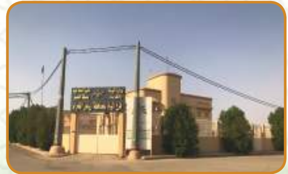
مبنى فرع المياه طريق الإسكان حي التعاون
